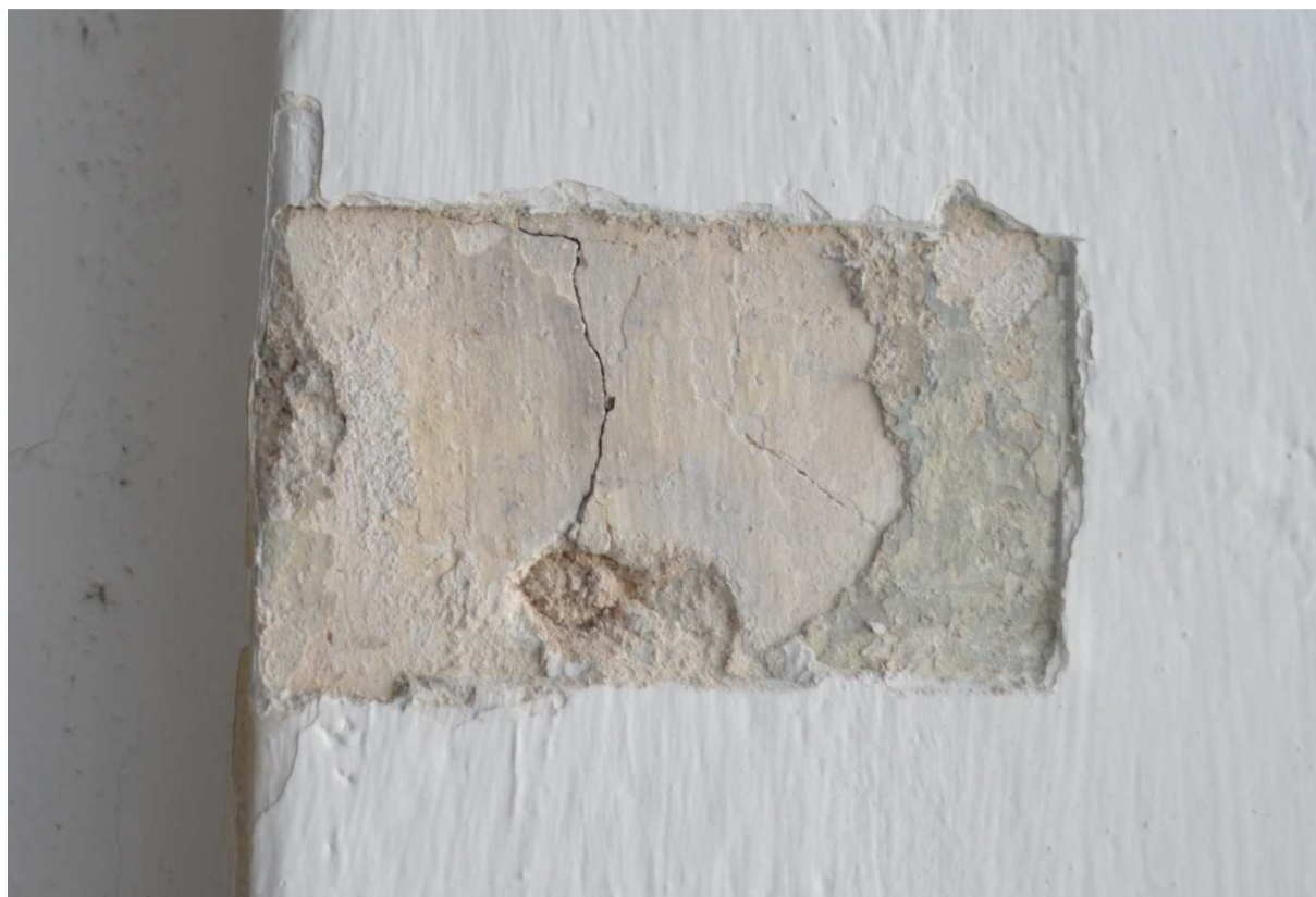
Sonda ve špaletě okna odkrývá nejstarší omítku s vápennými nátěry
